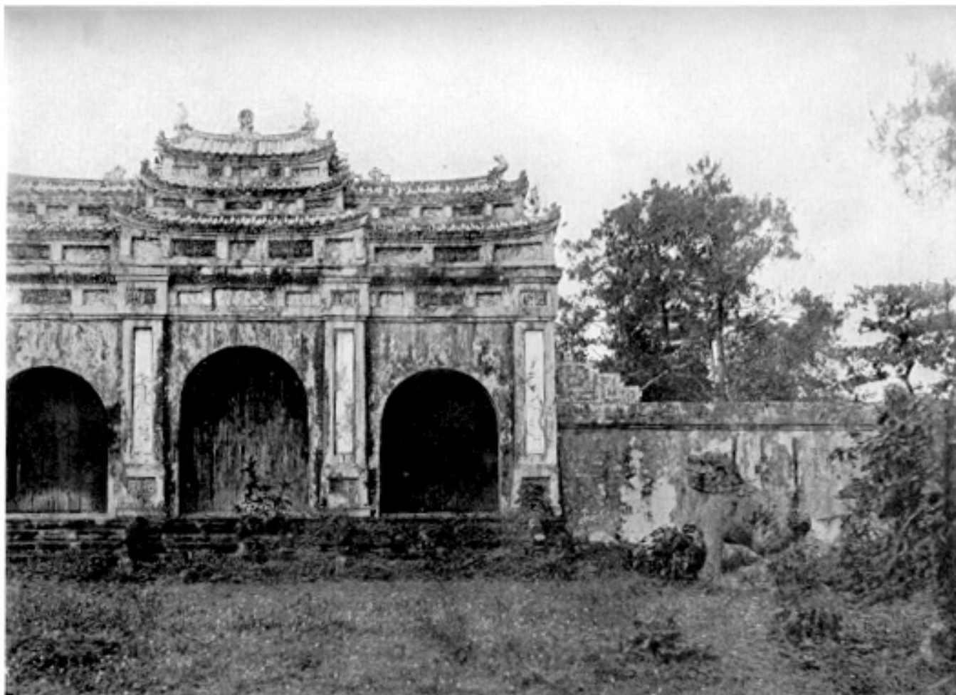
Planche LXXIX. — Au Tombeau de Minh - Mạng : la porte Đại - Hồng, de l'enceinte extérieure, avec Kỳ - Lân (Photographie communiquée par M. Ch. Lichtenfelder ).
